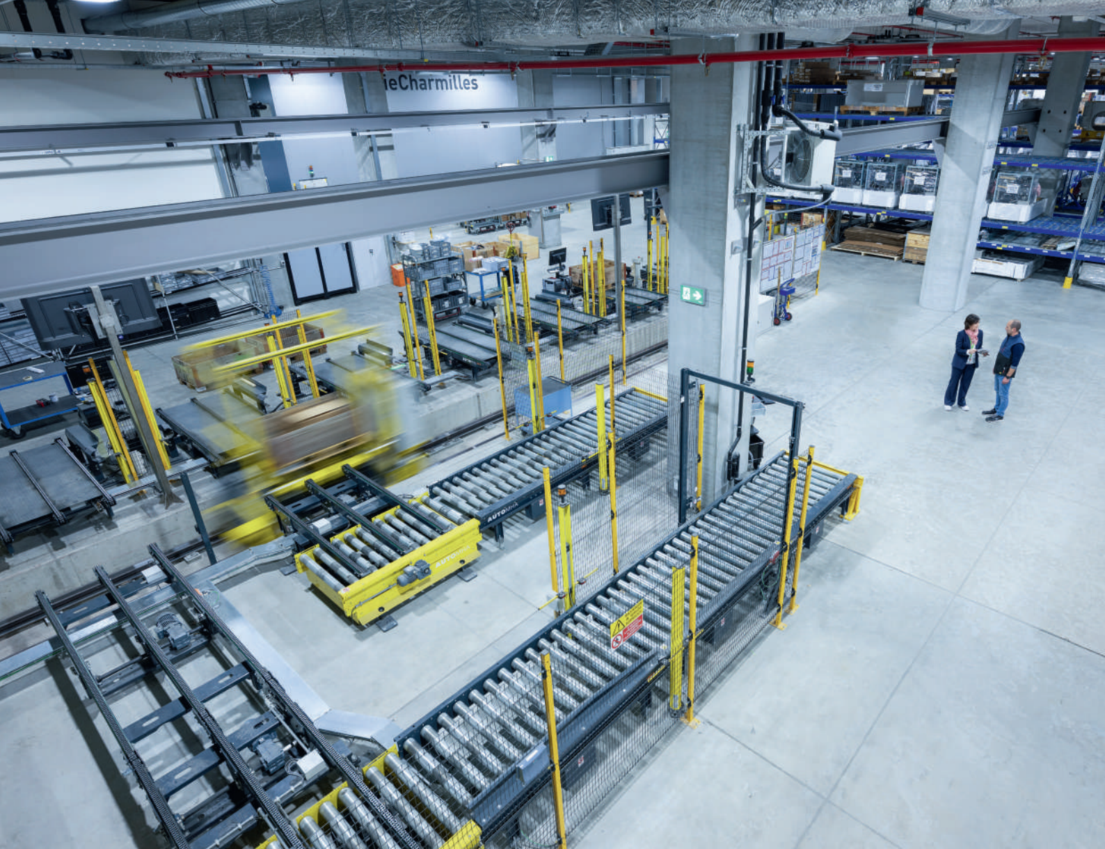
Dans le cadre de la modernisation de l'usine d'AGIE CHARMILLES à Losone, l'ensemble du flux de marchandises, y compris les livraisons, a été optimisé
